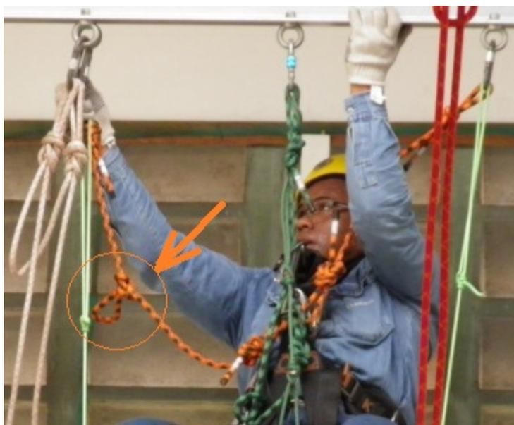
Foto mostrando o nó para reduzir o encordoamento
